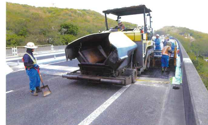
後方区間のレベリング層舗設が終わり、午後は前方区間の舗設に移る
