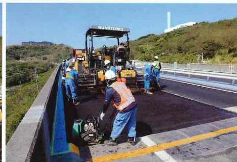
レベリング舗装厚40mm(ここでは余盛りを見込んで表層舗装厚7.5mm)の舗設が進む。ジョイント部、縁石際も丁寧に
