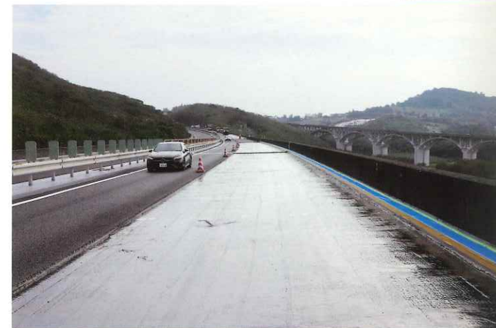
左=防水材塗布の終わった南風原高架橋、この付近の追越車線には床版補修が施されている 右上=防水材吹付け作業中の本村工業の皆さん、追越車線側の吹付け作業は車両走行時は一旦止める 右下=管理者立会いの下、ピンホール探知機で床版防水層の空隙をチェック。南風原高架橋の施工箇所8区画のうち7区画はすでに舗装まで終え、残るは取材当日施工の1区画のみ
