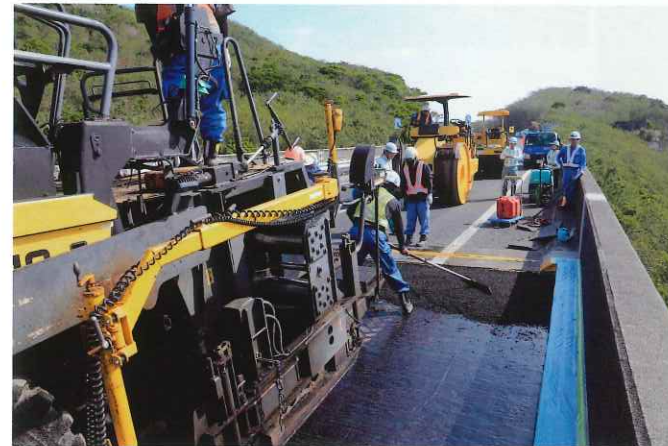
フィニッシャーアイロン台据付け
