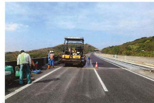
本日の舗装起点、橋長は300m、舗装区間は那覇IC方向の後方・前方2箇所合わせて220mほどになる
