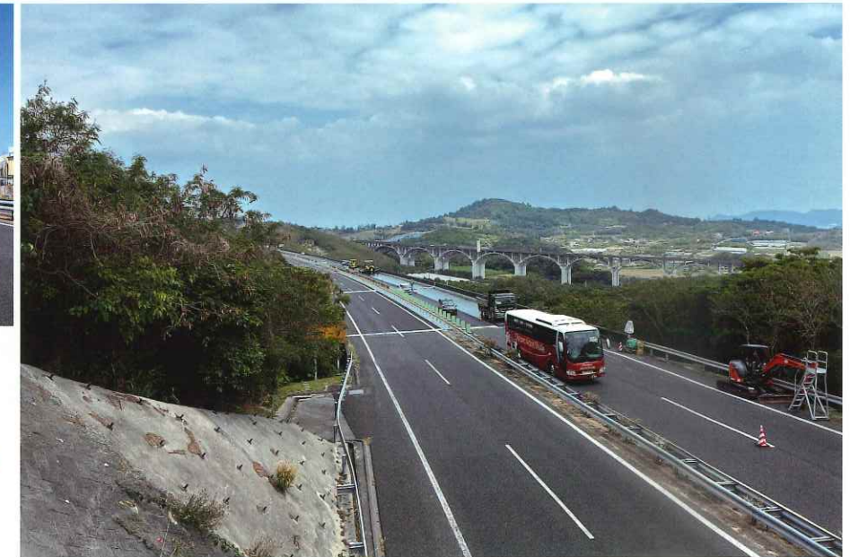
午後、検温を済ませたダンプが舗設位置へ、最終区間のレベリング舗装が始まる。中央奥から右のアーチ橋が那覇空港自動車道
