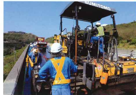
レベリング舗装厚40mm(ここでは余盛りを見込んで表層舗装厚7.5mm)の舗設が進む。ジョイント部、縁石際も丁寧に
