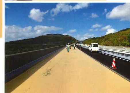
左=防水材塗布の終わった南風原高架橋、この付近の追越車線には床版補修が施されている 右上=防水材吹付け作業中の本村工業の皆さん、追越車線側の吹付け作業は車両走行時は一旦止める 右下=管理者立会いの下、ピンホール探知機で床版防水層の空隙をチェック。南風原高架橋の施工箇所8区画のうち7区画はすでに舗装まで終え、残るは取材当日施工の1区画のみ
