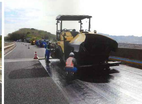
レベリング舗装を控えてスタンバイする大和土木の皆さん
